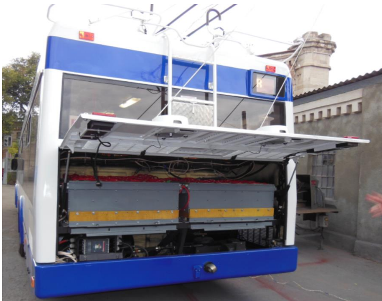
Amplasarea bateriei de acumulatori
